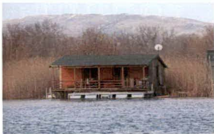
фотографија објекта и локације
