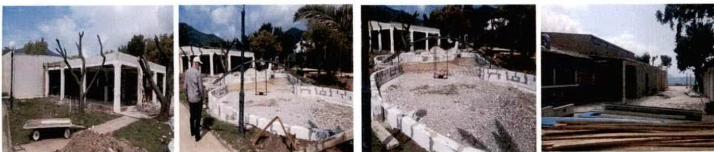
Fotografije lokacije i radova
