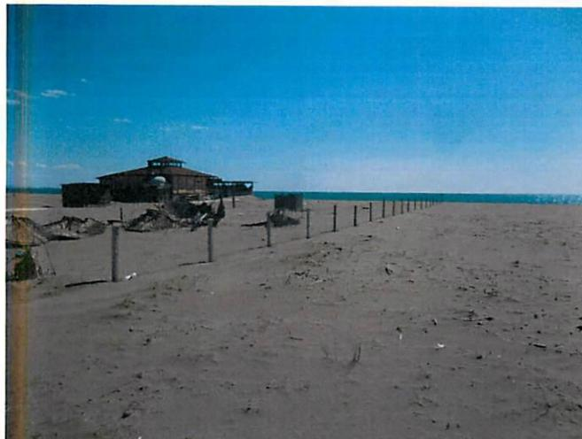
U nastavku istih ograda, izvršeno je postavljanje betonskih stubova na svakih cca. 2 metara, u dužini od cca. 50 metara do same kapije. Sa druge strane puta, izvršeno je ograđivanje sa istim betonskim stubovima, i bodljikavom žicom, u dužini od cca. 100 metara.
