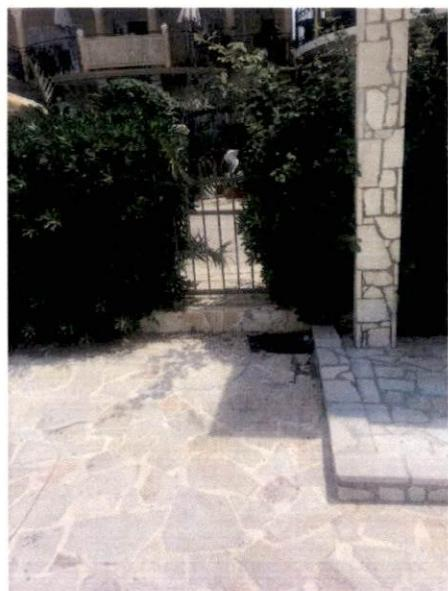
Na istočna strani kuaplišta, prema lokalnoj saobraćajnici, postoji metalna ograda dužine cca dužine 70m i visine cca 1,5m postavljena između betonskih stubica obloženih kamenom.
