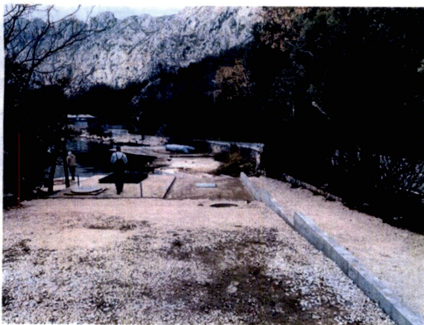
Ulaz na lokaciju sa izgradjenim parapetnim zidom u cilju omogucavanja prolaza do susjedne ponte
